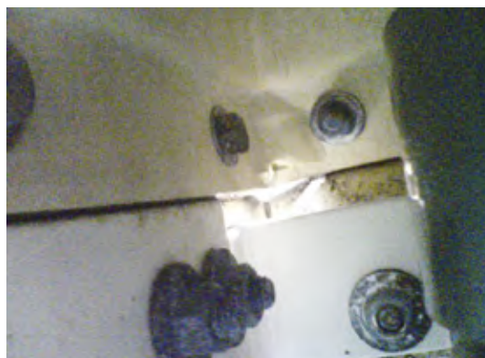
水槽パネルの継ぎ目に隙間が生じている
