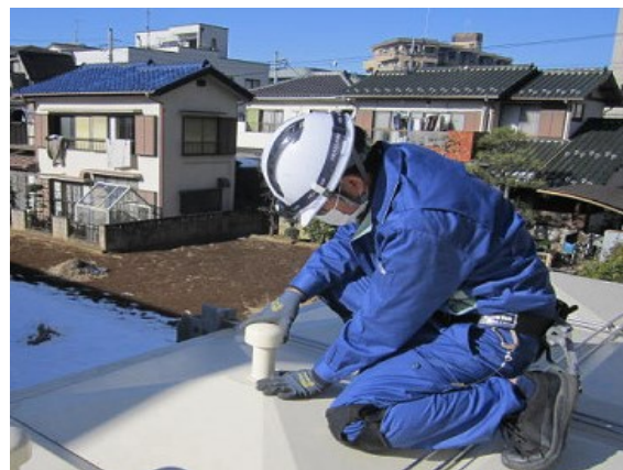
簡易専用水道検査の様子
