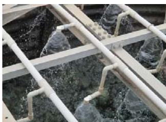
天城抗火石高速散水ろ床法と活性汚泥法併用プラント
