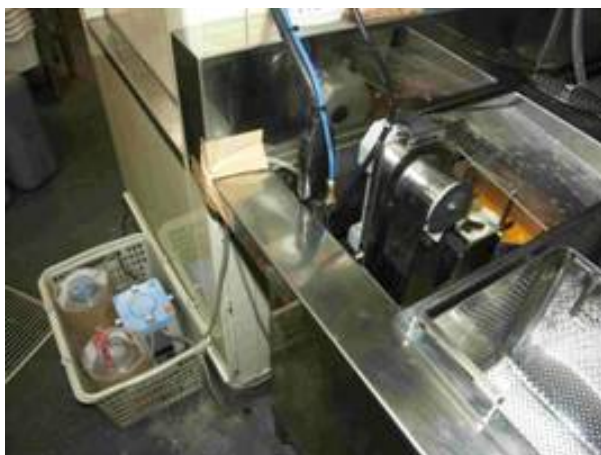
(19) ペリスタポンプ設置状況
