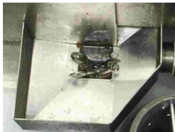
(17) 流入水採水口設置状況
