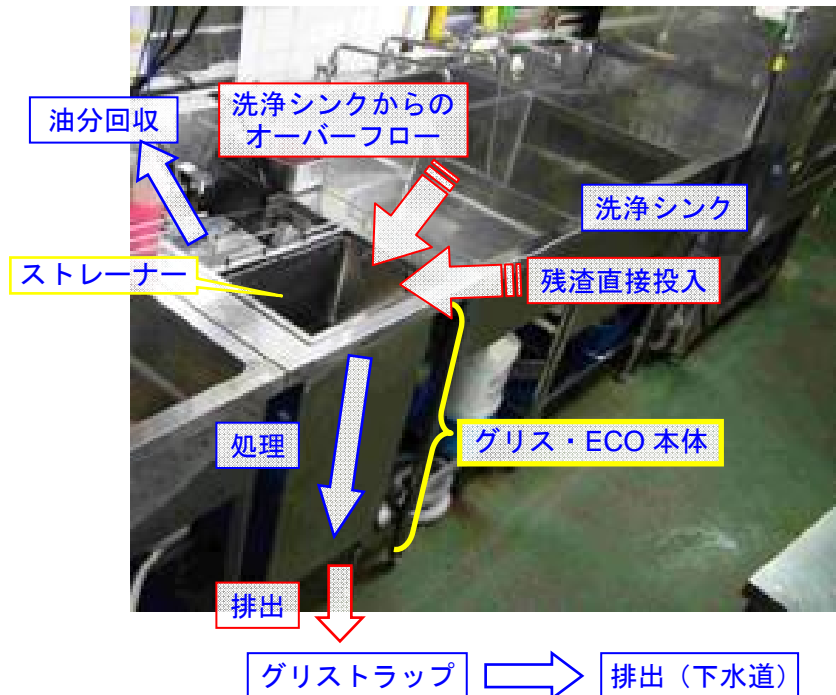
図3-1 実証対象技術の機器構成及び処理フロー（実証試験実施場所と同じフロー）
