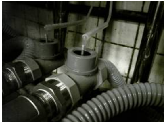
(16) 処理水採水口設置状況
