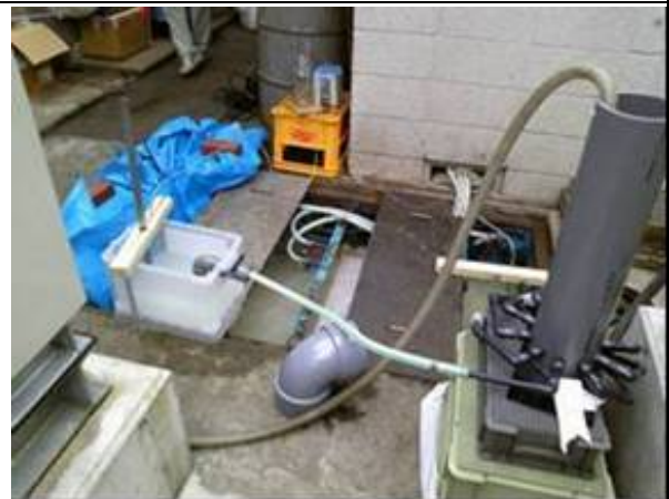
(10) グリストラップへの流入水減量の実証試験（1/10 流入水量実証試験）による採水状況 三角堰流量計（左側）とブルーシートで作成した排水受けで、厨房からの排水の全量を一旦受け、10分の1分配器（右側）を用い流入水量を10分の1に減量させてから、三角堰流量計（左側）でグリストラップへの流入水量を測定した。
