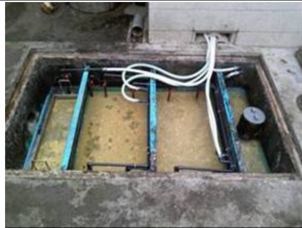
(7) ECOTRIMから伸びるビニールチューブ及び散気管（10月10日） 散気管はグリストラップの底に設置した。
