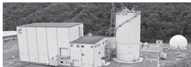
<寄居バイオガスプラント>
